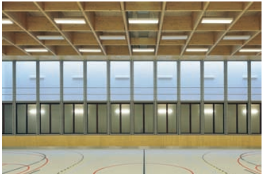
La salle, qui fait 24,50 m de long sur 17,10 m de large et 7 m de haut, est adaptée à la pratique du mini-foot, du basket, du volley et du badminton.
