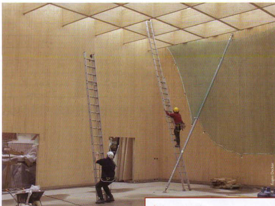
Murs, toiture et plancher en panneaux multicouches.
